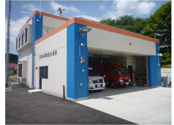
【消防庁舎復旧事業】 大船渡地区消防組合大船渡消防署 三陸分署綾里分遣所
